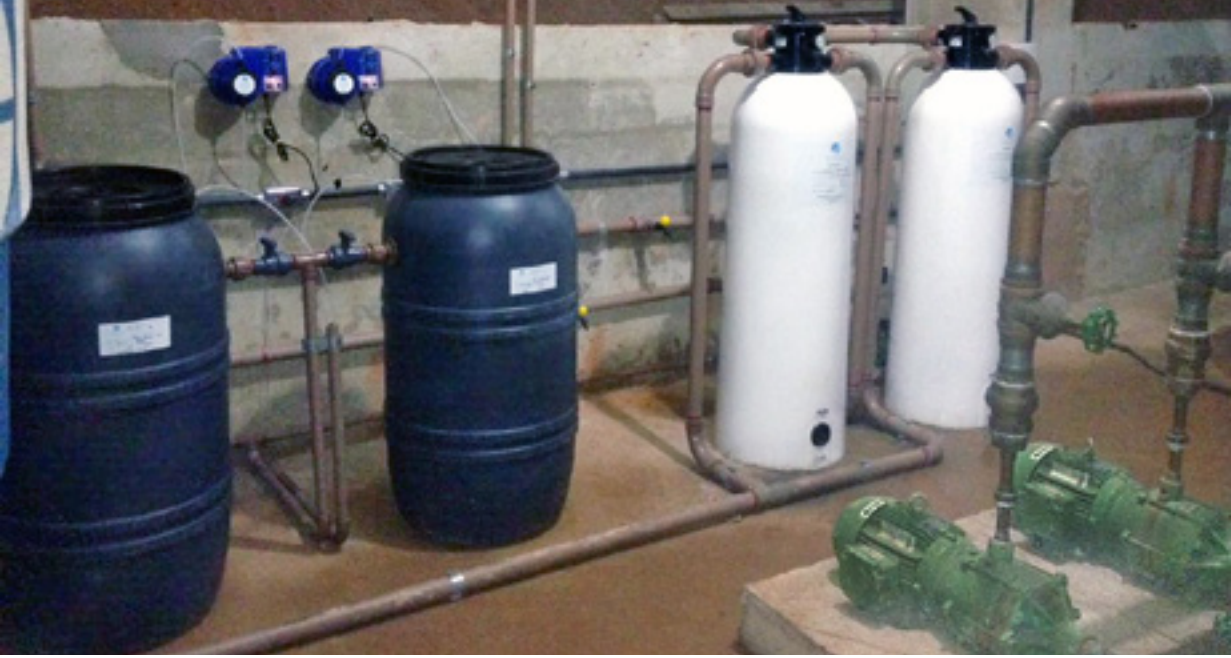
Estação de tratamento de água instalada em parceria com HidroTR
